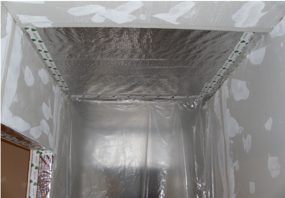
Absperrbahn und Verkleidung Gipskarton
