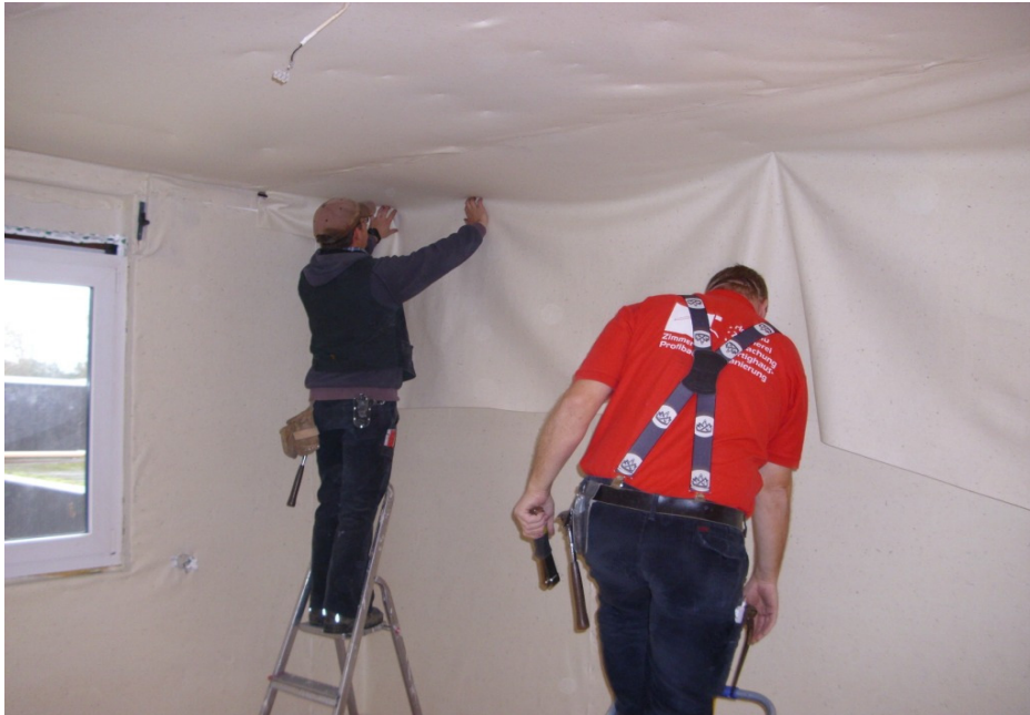
Einbau Absorber-Vlies
